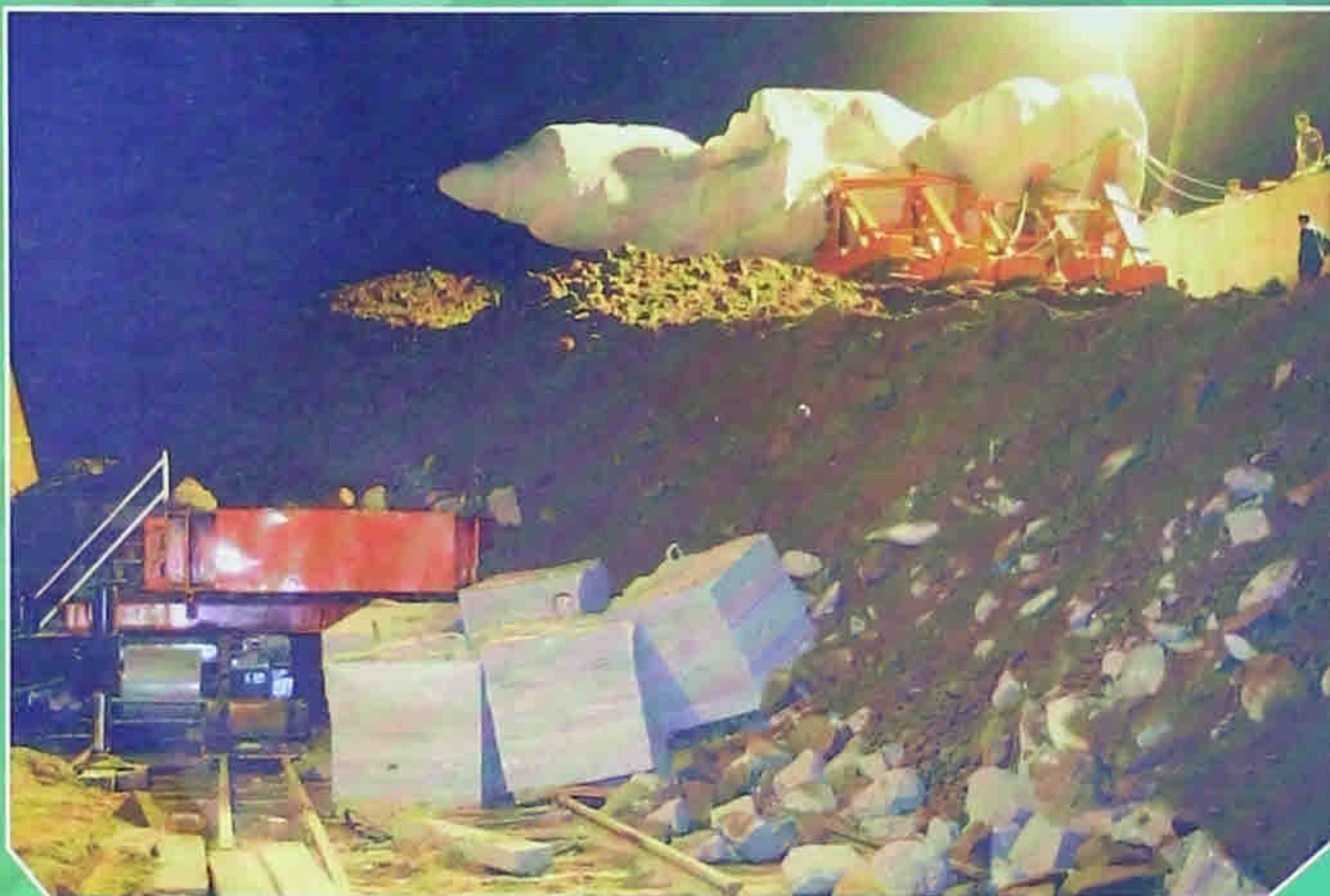
ရုပ်ပွားတော်မြတ်ကြီးကို ပင့်ဆောင်ပြီး ထူမတ်ရန် တန်ငှာ၀၀ ဂျှိုက်များဖြင့် ပင့်မြှောက်၍ သစ်သားတုံးများ၊ ကွန်ကရစ်တုံးများ၊ မြေသားများ ခုခံဆောင်ရွက်ခြင်းလုပ်ငန်း များကို ဆောင်ရွက်စဉ်
